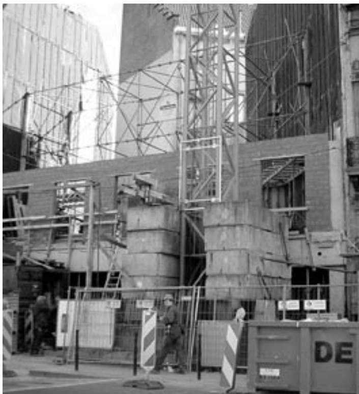
Nieuwe sociale woningen in de Masuistraat
