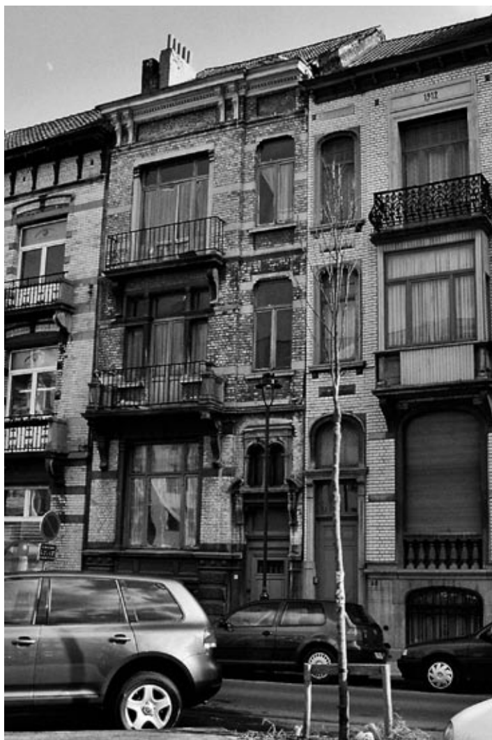
Verkrotting aan de Herzieningslaan
