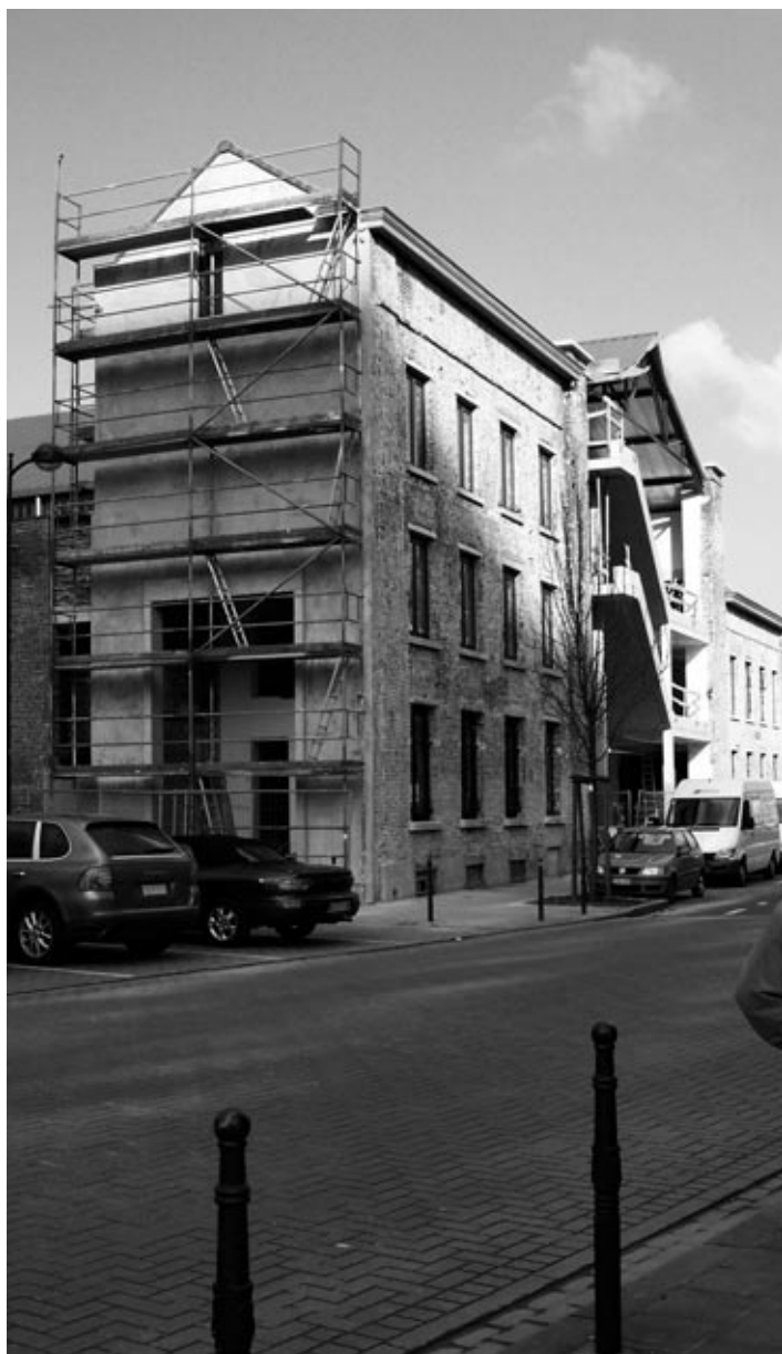
De tramstelplaats wordt verbouwd tot polyvalente zaal. Foto: Michel Demol
